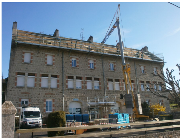
Réfection de la toiture
