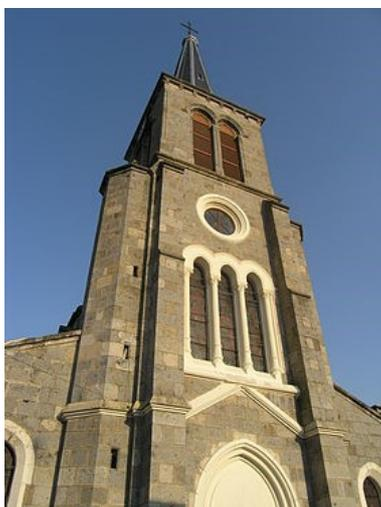
Ces travaux, sur la façade, au dessus de la grande porte, consistent au remplacement des pierres qui s'effritent et se détachent, à la réfection d'enduits, de joints et de badigeons. Ils seront réalisés au cours du 2ème trimestre 2017.
